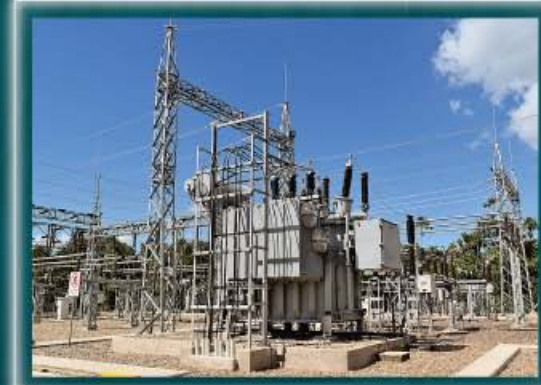
Construcción y Montaje Subestación Yucumo
