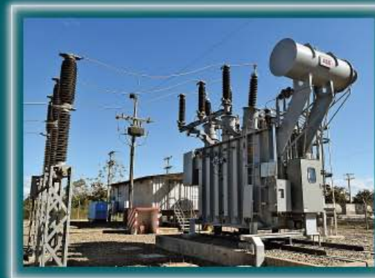
Construcción y Montaje Subestación San Borja
