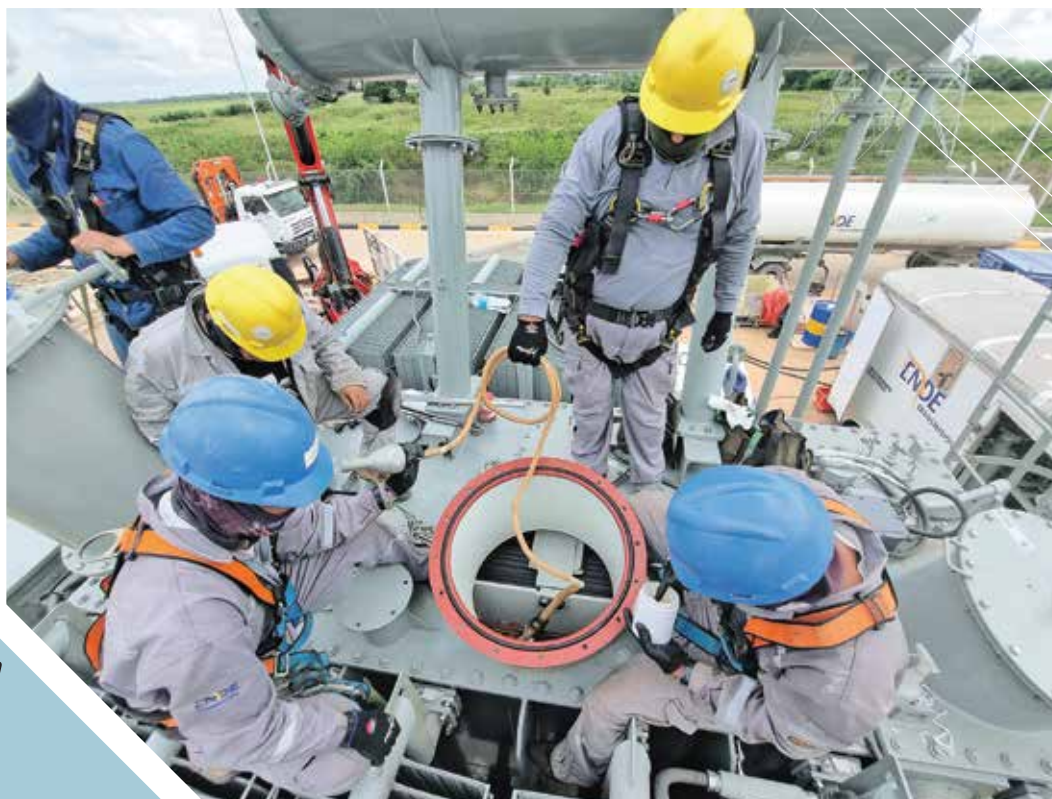
Trabajos en Subestación Paraíso 230/115 kV, Beni Categoría: Personal Foto: Joel Atahuichi
