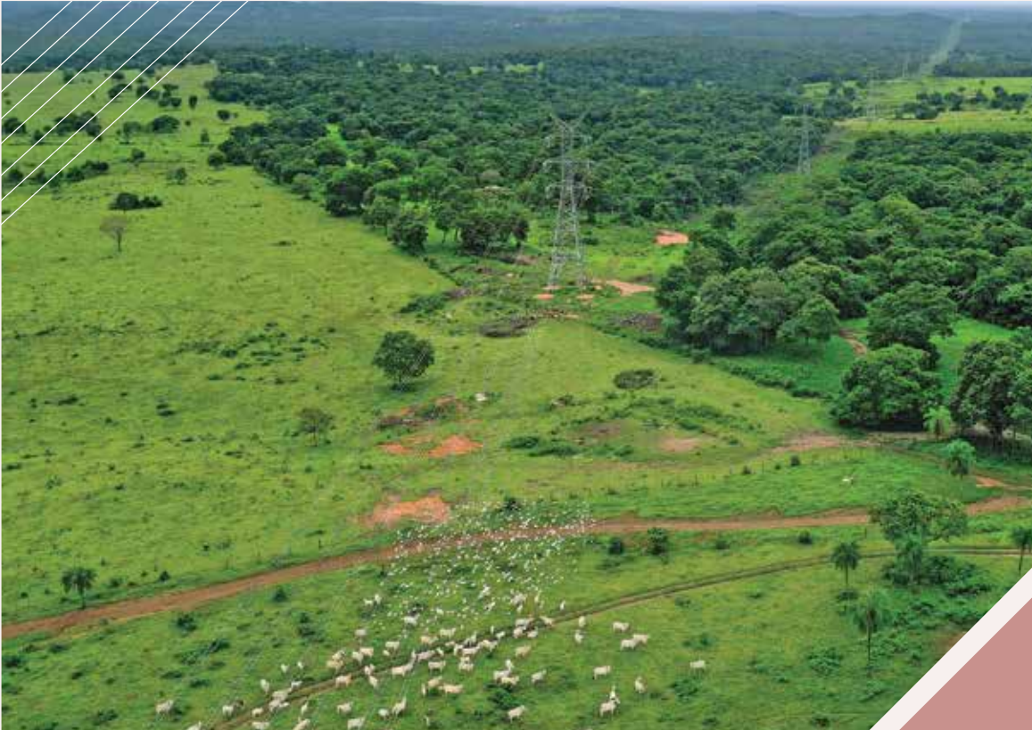
Línea 230 kV Los Troncos - Guarayos - Paraíso - Trinidad. Beni Foto: Archivo ENDE Transmisión
