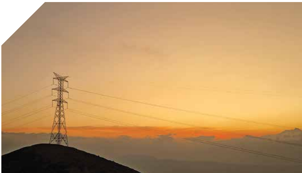
Línea 230 kV Santivañez - La Palca, Cochabamba. 2do. lugar, Categoría Técnica Foto: Ramiro Vargas
