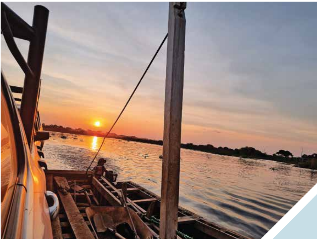
Línea 115 kV Trinidad - San Ignacio de Moxos (Cruce en pontón, Puerto Varador), Beni Categoría: Especial Foto: Joel Atahuichi
