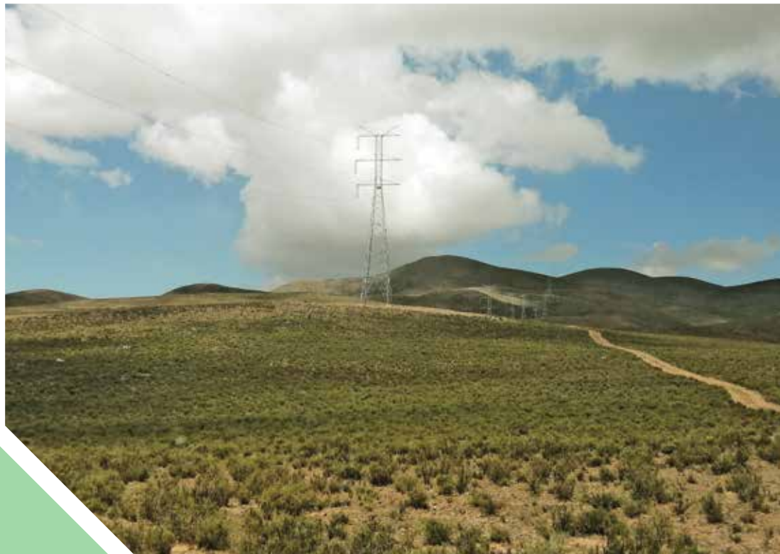
Línea 230 kV Torrehuayco - Carreras, Carretera Tupiza - Tarija Categoría: Técnica Foto: Angela Campos
