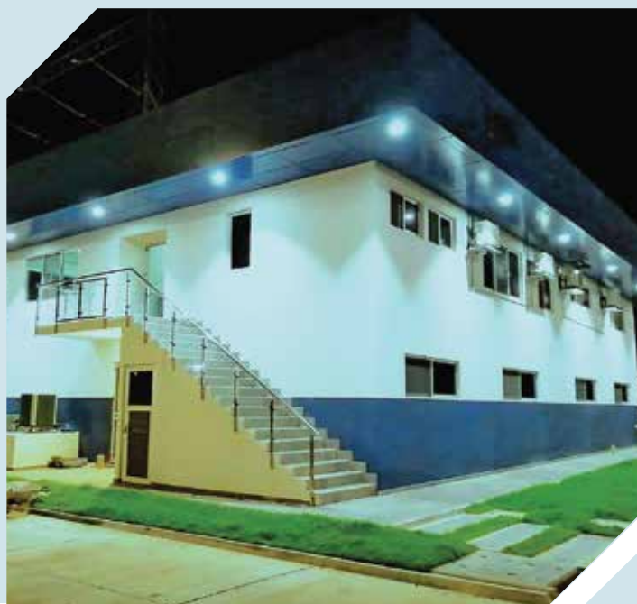
Sala de control en Subestación Carrasco 500 kV, Cochabamba. Categoría Técnica Foto: Gustavo Torrico
