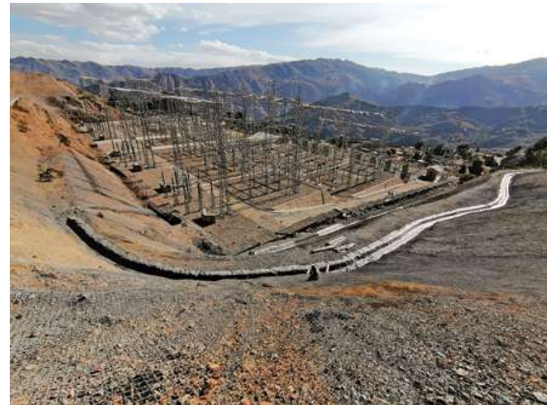
Subestación La Palca 230 kV. Tuhuaco - La Paz Foto: Angela Campos
