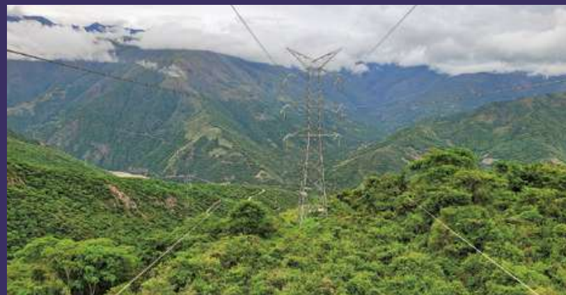
Línea 230 kV Santivañez - La Palca. Miguillas - La Paz. Foto: Jorge Pinto
