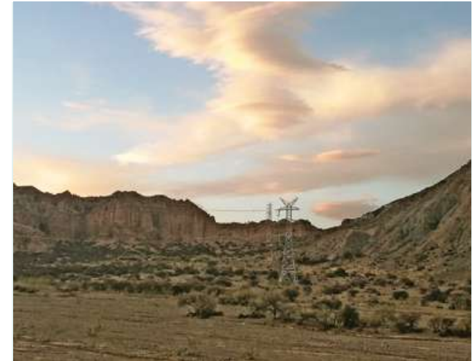
Línea 69 kV Atocha - Torrehuayco - Tupiza - Potosí Foto: Angela Campos
