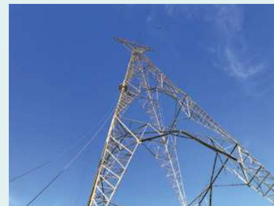
Trabajos en estructura 071, Línea 230 kV Warnes - Urubó, Santa Cruz Foto: Myriam Gutiérrez
