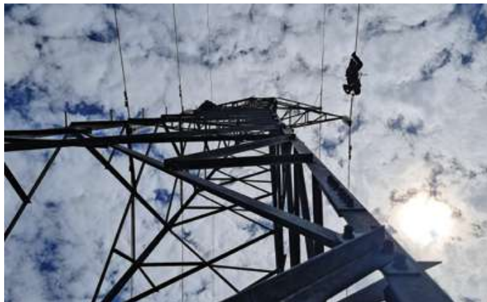
Trabajo en Línea 115 kV San Ignacio de Moxos - Trinidad, Beni Foto: Joel Atahuichi
