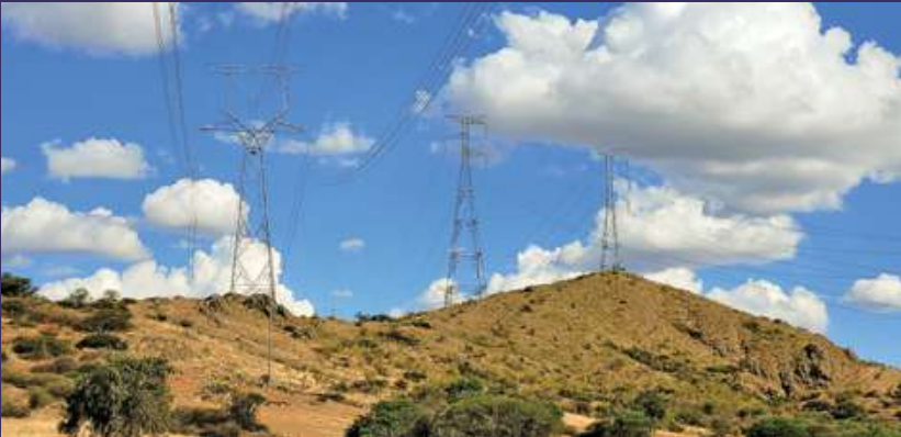
Paralelismo de líneas en 500 kV y 230 kV, Santivañez - Cochabamba. Foto: Jorge Pinto
