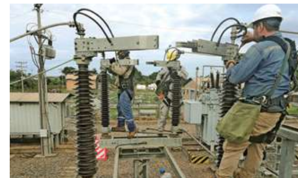
Trabajos en Subestación San Borja 115 kV, Beni Foto: Joel Atahuichi
