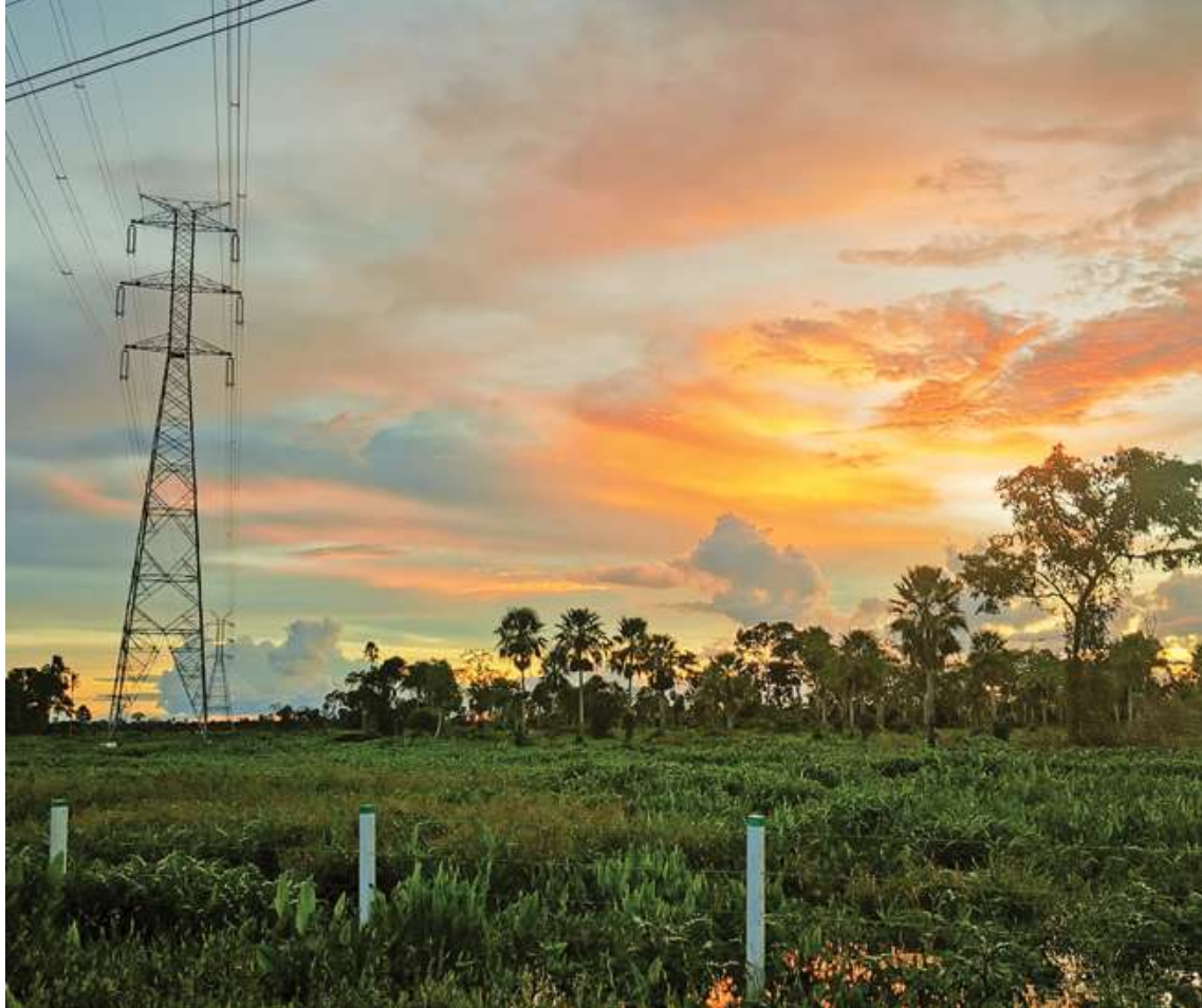
Línea 230 kV, Los Troncos - Guarayos - Paraíso - Trinidad. Foto: Archivo ENDE Transmisión
