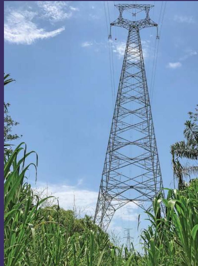
Línea 500 kV Carrasco - Santivañez. Cruce de río Sacta, Cochabamba Foto: Myriam Gutiérrez
